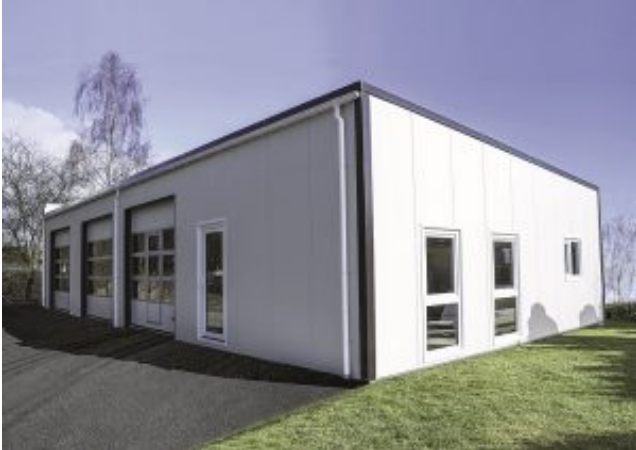
Der Neubau einer Halle für
