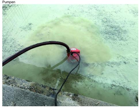
Wenn Schmutzwasser steht und stört, helfen die kompakten Restwasserpumpen von Tsurumi beim Beseitigen.
