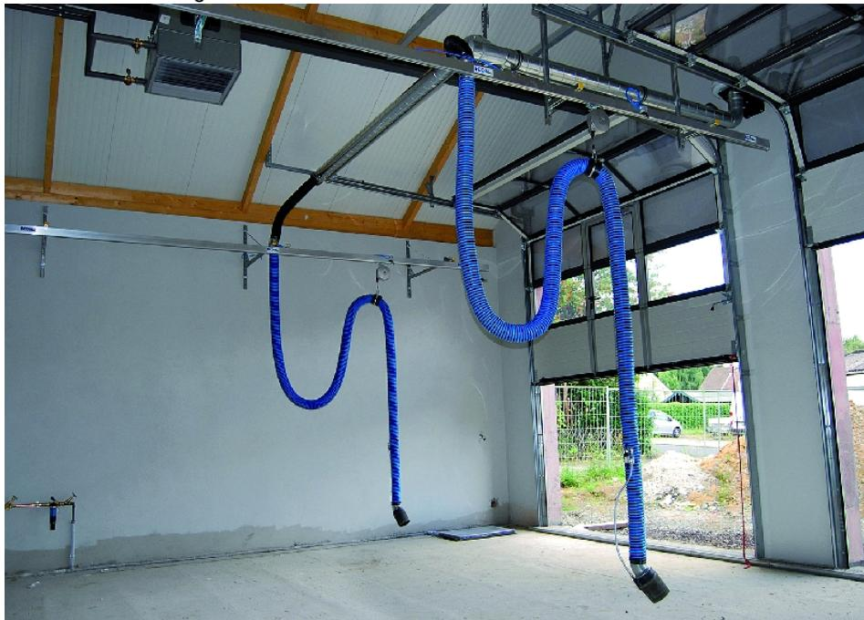
Ein Installationsbeispiel für das Feuerwehr-Absaugsystem »Econ Alarm Sog«. Beim Anfahren löst sich der Schlauch vom Auspuff.
