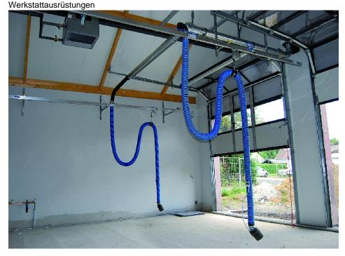
Ein Installationsbeispiel für das Feuerwehr-Absaugsystem »Econ Alarm Sog«. Beim Anfahren löst sich der Schlauch vom Auspuff.
