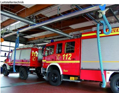
Der pneumatisch angekoppelte Trichter umschließt den Auspuff luftdicht und verhindert so das Austreten von Abgasen 100%ig (ecovent).
