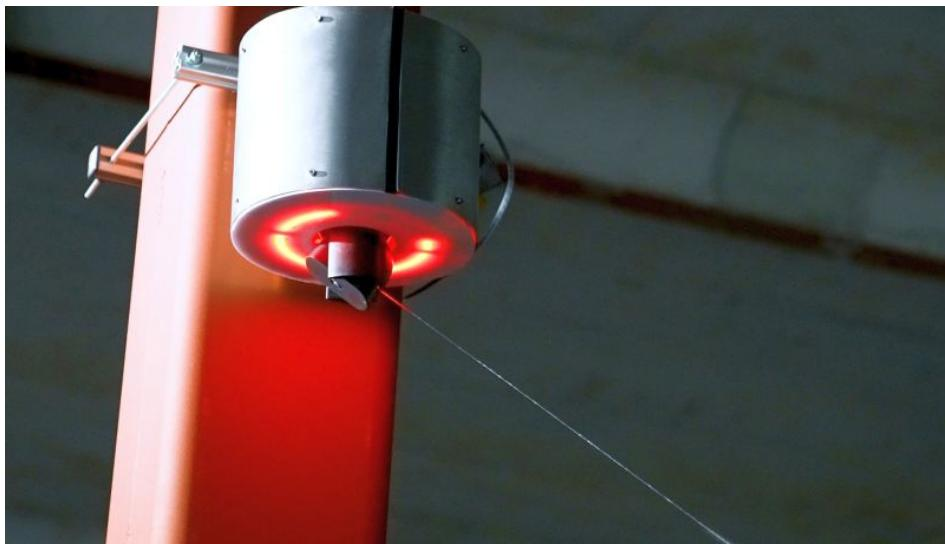
Die Software (KI) erkennt ein Feuer und löst das integrierte Löschesystem aus. Alle erforderlichen Komponenten wie beispielsweise die Steuerung, die Mechanik, Pumpen und Löschmittelbehälter sind in dem System enthalten (Bild: [Guardian Technologies](#)).
