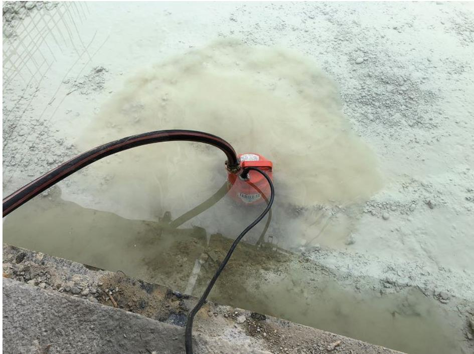
Wenn Schmutzwasser steht und stört, helfen die kompakten Restwasserpumpen von Tsurumi beim Beseitigen (Bild: Tsurumi).
