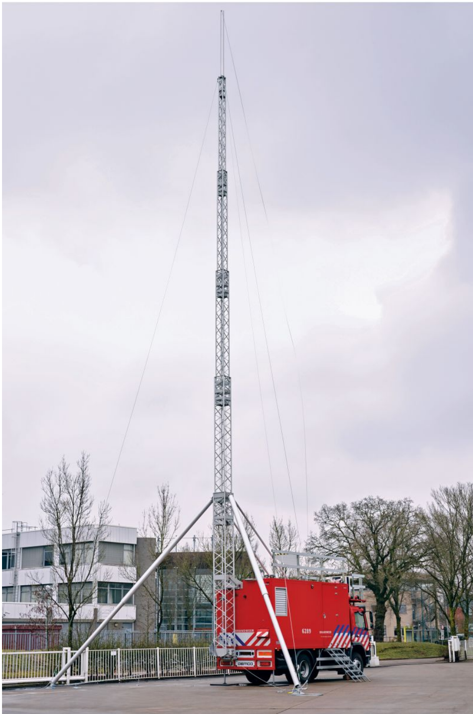
4x4-Offroad-Fahrzeug zur Tetra-Netzunterstützung mit einem 30 m hohen Teleskopmast (Bild: Gemco).
