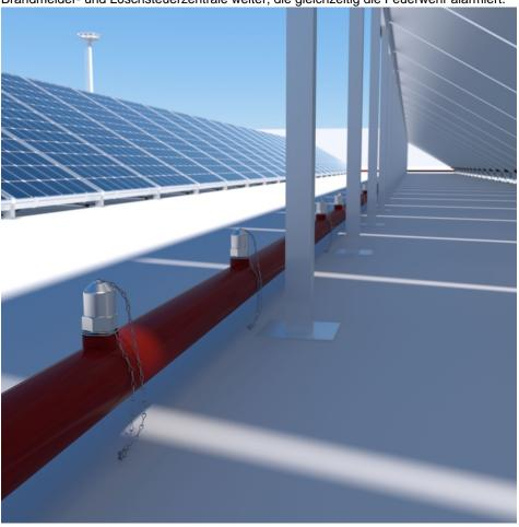
Speziell entwickelte PV-Düsen sorgen mit ihrer gezielten Anordnung für ein flächendeckendes Sprühbild (Bild: Minimax).
