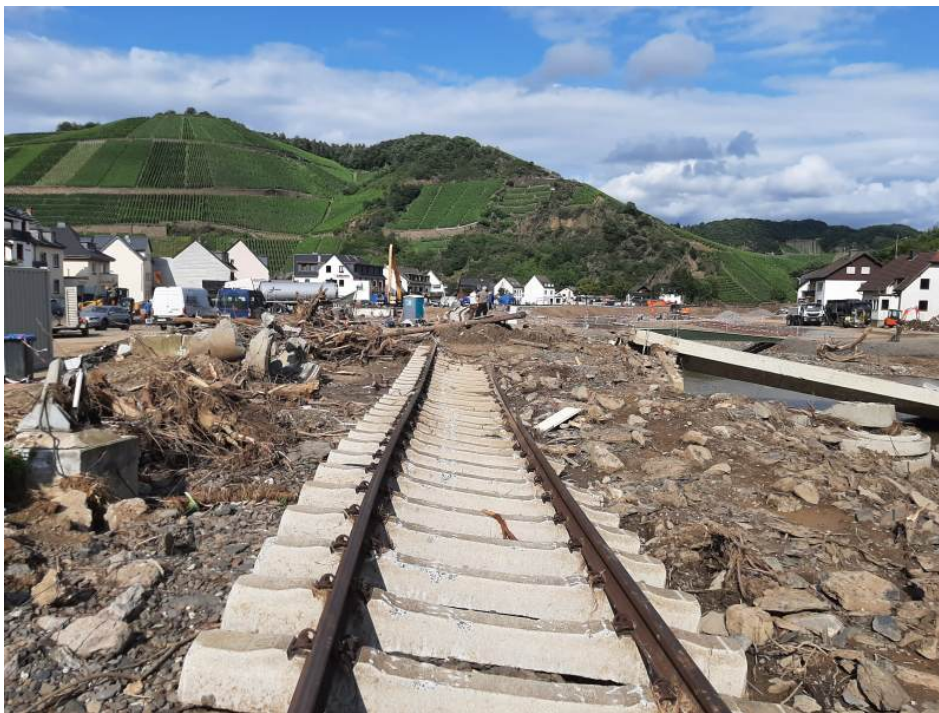
Eine vom Hochwasser zerstörte Bahnstrecke im Ahrtal (Bild: Akademie
