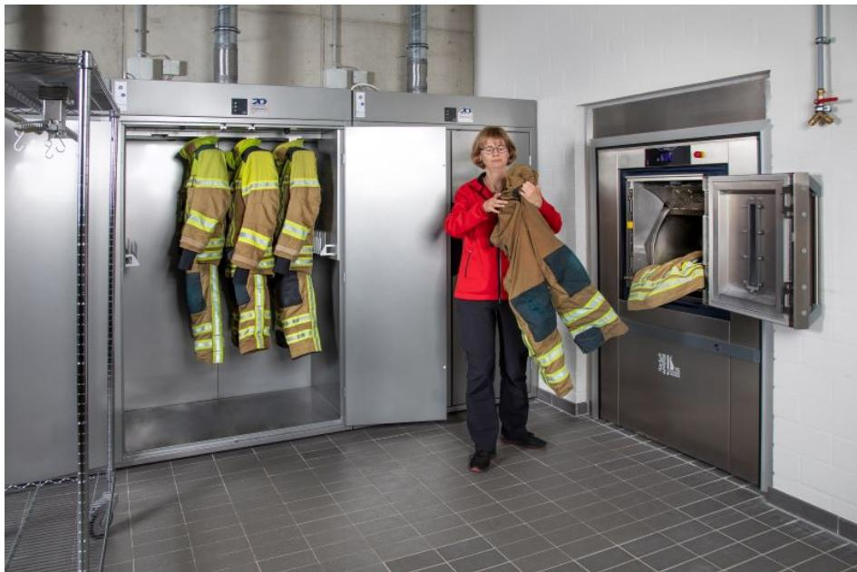
Zum Feuerwehr-Paket von Electrolux Professional gehören Trennwand-Waschmaschinen sowie Trockenschränke, die speziell für die schonende Trocknung der anspruchsvollen Schutanzüge und die Reaktivierung der Imprägnierung entwickelt wurde (Bild: Cornelia Naumann / Electrolux Professional).
