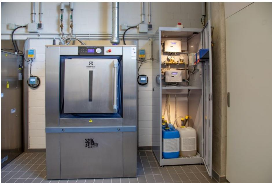
Für eine hygienisch einwandfreie Aufbereitung von kontaminierten Feuerwehruniformen sorgt der Dreiklang aus Trennwand-Waschmaschine mit »ClarusVibe« Steuerung sowie eine in einem Chemikalienschutzschrank vor Zugriff geschützte Dosiertechnik (Bild: Cornelia Naumann / Electrolux Professional).
